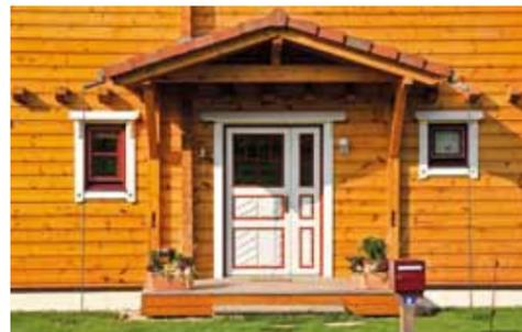
Zadržite razmak od min. 20 cm između drvenih konstruktivnih elemenata i tla
